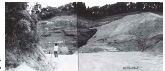
砂利採取(左奥)と残土搬入(右)が同時に行われている市原市勝間
